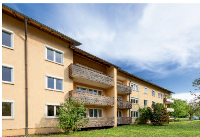
Diese Sanierung wurde verschoben: Aeulestraße 33 und 35.
