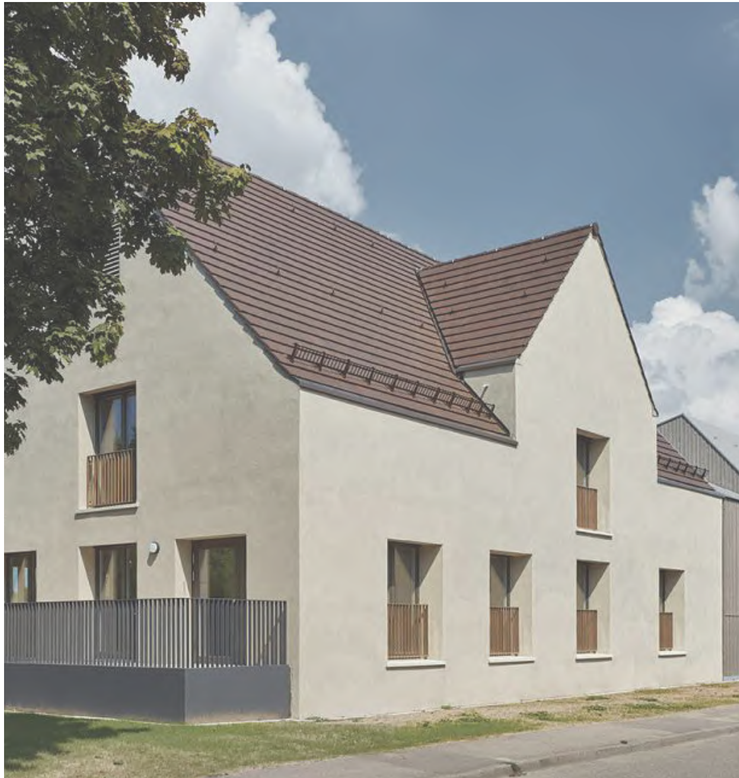
Abb.18: Objekt: Kinder- und Familienzentrum in Ludwigsburg, Architekturbüro VON M; Foto: Zooey Braun https://www.baunetz.de/meldungen/Meldungen-Kinder-_und_Familienzentrum_in_Ludwigsburg_4676451.html
