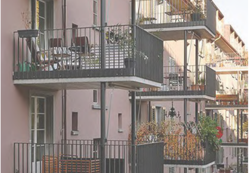
Abb.17: Objekt: ABZ Wohnsiedlung Sihlfeld, Zürich, Schweiz; Rolf Schaffner dipl. Architekt ETH SIA http://www.schaffnerarch.ch/portfolio.html
