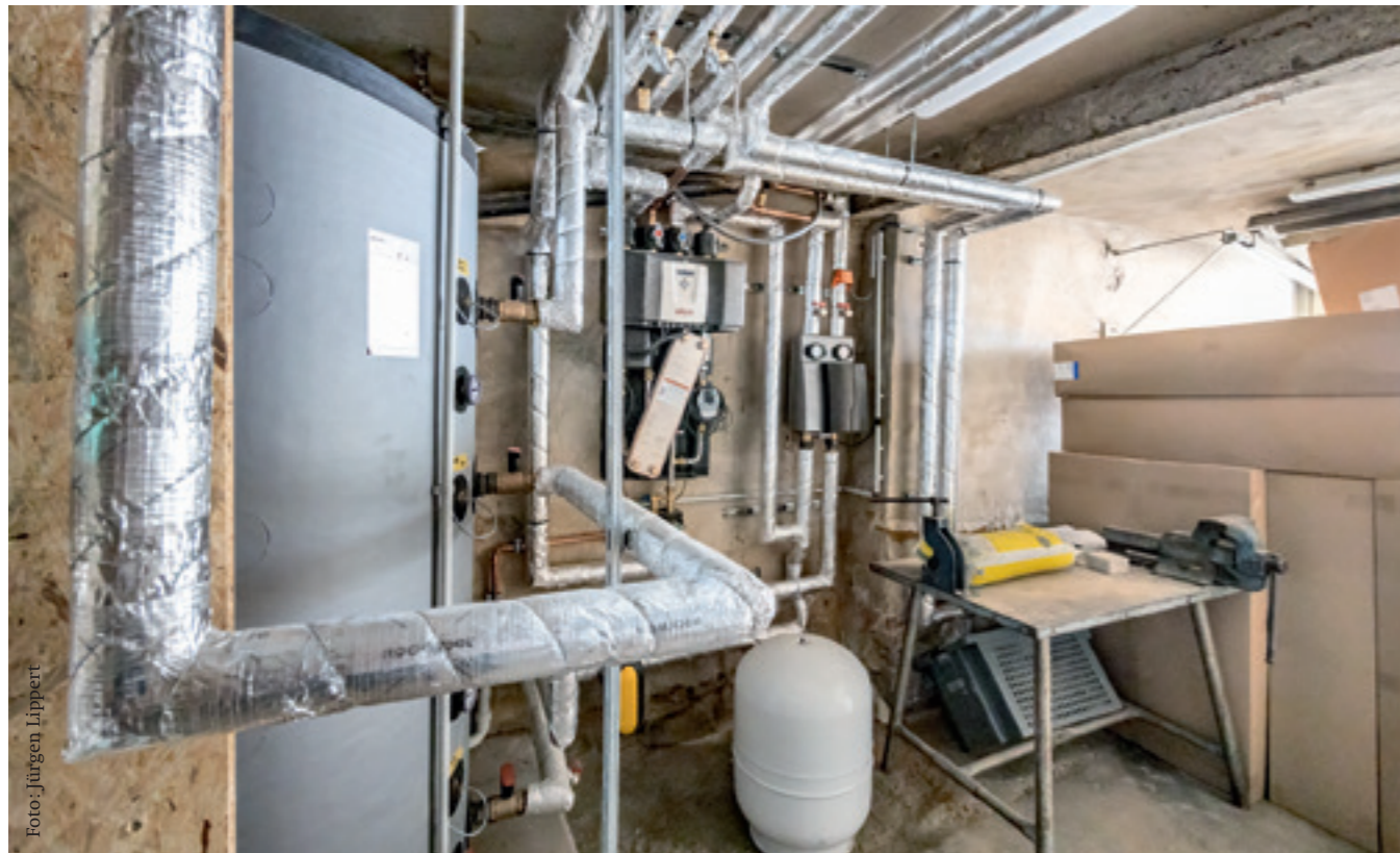
Eine neue Heizung für die Burgsteige 6
